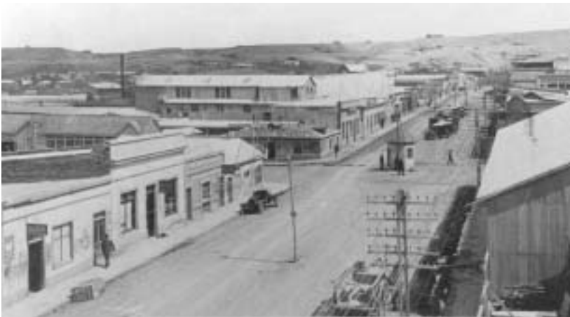
Vista de la calle San Martín en Comodoro Rivadavia, a principios de 1900.
