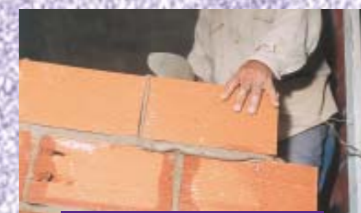
... la mezcla para unir ladrillos.
