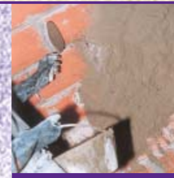
... la mezcla para el revoque.
